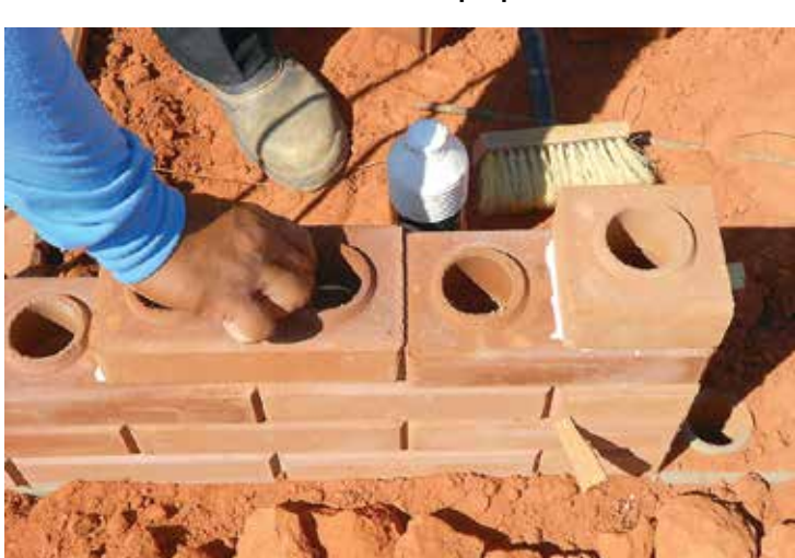
Tijolos ecológicos: dificuldade com mão-de-obra
