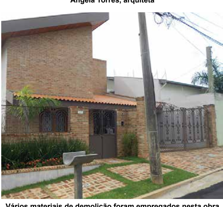
Vários materiais de demolição foram empregados nesta obra
